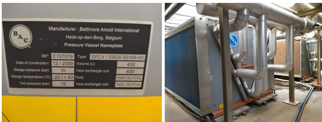
Detall i vista de torres de refrigeració obertes marca BAC model DFCV/S9026-S616B-AD
