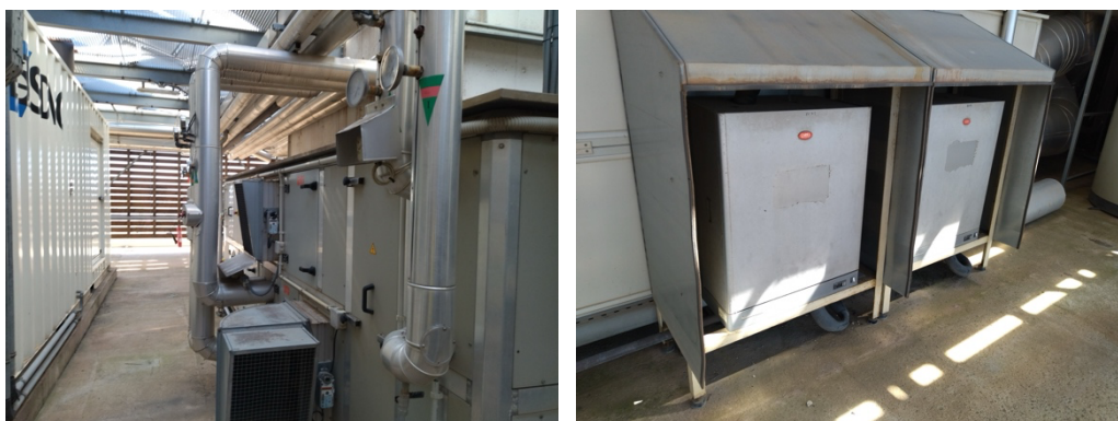
Vista de climatitzador de coberta a 6 tubs i amb humectació de vapor (elèctrica)
