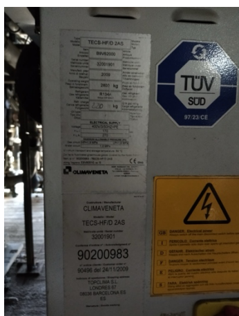
Detall refredadora levitació magnètica Climaveneta model TECS-HF/D 2AS.
