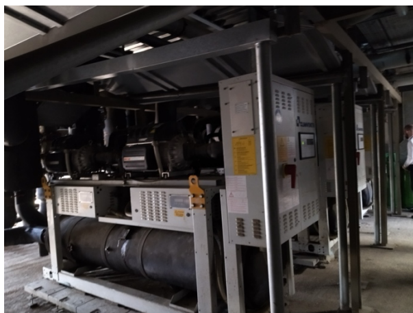
Detall refredadora levitació magnètica Climaveneta model TECS-HF/D 2AS.
