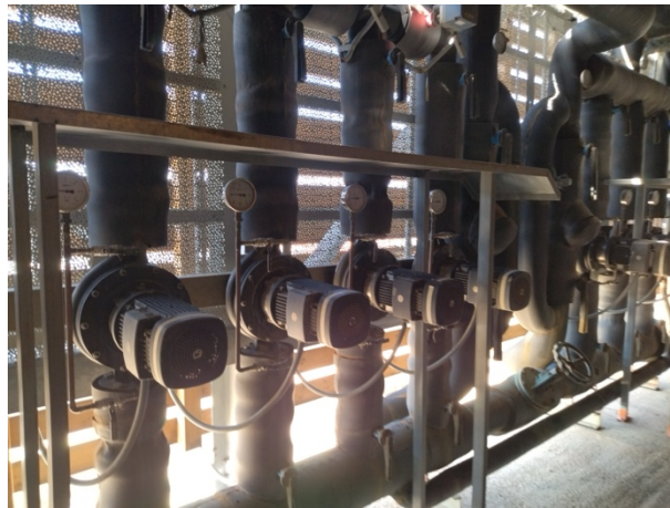
Detall col·lectors impulsió/retorn i unió (circuit refrigeració) i bombeigs.
